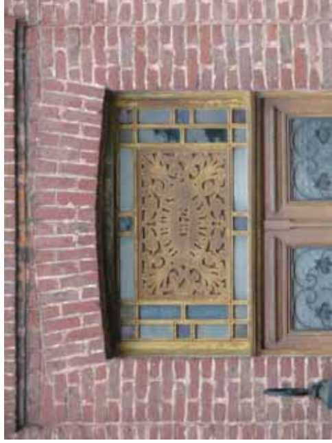
Détails d'impostes chantournées, aux initiales du propriétaire, portant une date de construction (photo de gauche, n°1522 rue du Bois ; photo de droite, n°257 de la même rue).
