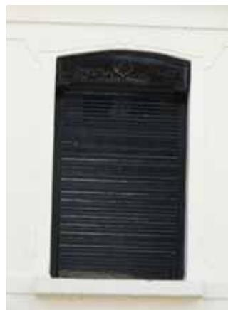
Un exemple de volet roulant d'origine, intégré dans la maçonnerie de la baie, dont le caisson est caché par un lambrequin (cf. photo ci-dessous).
