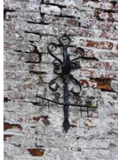
Sur ce fer d'ancrage figure à la fois la date de construction de la bâtisse et les initiales du propriétaire : 1844 / AH.
