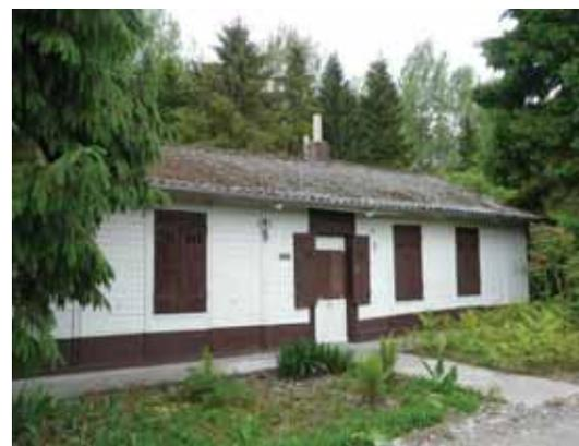
Le bois est souvent utilisé en bardage. Les planches, généralement posées à clin (légèrement inclinées), servaient à protéger les murs de torchis.
