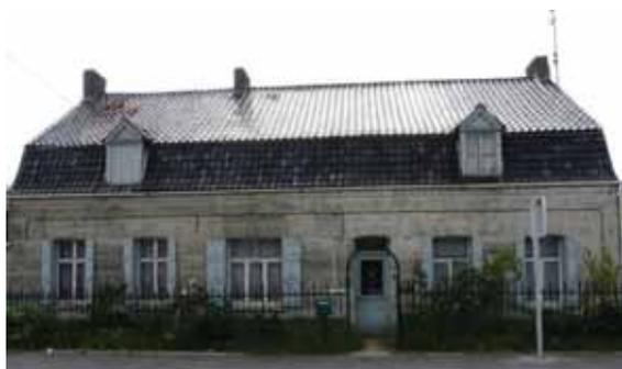
Sur ce corps de logis agricole, les pannes mécaniques en place sont vernissées.
