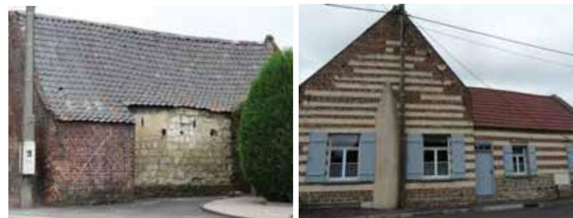
Deux exemples d'utilisation de pierre blanche en maçonnerie : sur l'un, une partie de mur est entièrement montée avec des blocs appareillés de craie, sur l'autre, c'est la mise en œuvre du rouge-barre (alternance d'assises de briques et d'assises de pierre) qui prime.
