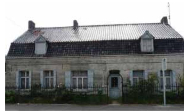
La façade principale du corps de logis de cette ferme est entièrement recouverte d'un enduit digité.
