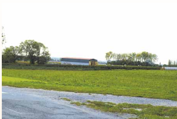
Zoom sur le bâtiment agricole
