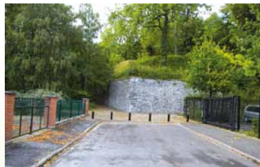
Accès côté ville
