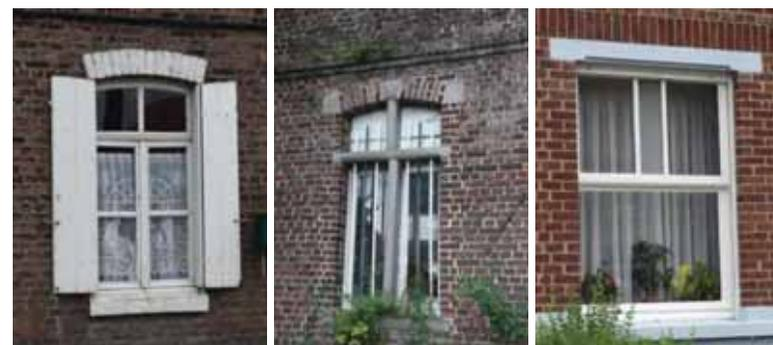
Ces fenêtres, d'époque différente, comprennent toutes une imposte en partie haute. La partie inférieure s'ouvre soit grâce à deux ouvrants (photo de gauche), soit en guillotine (photo de droite). Les huisseries et les volets, quand ils sont présents, sont en bois.
