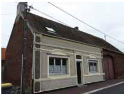
Dans les années 1900 apparaissent les enduits dits "gravillonnés" et "digités". Le "gravier roulé" (ou "gravié lavé", enduit gravillonné), consiste à appliquer sur un enduit frais des graviers de teintes et de tailles différentes. L'artisan fait rouler ces derniers à l'aide d'une taloche dans des compartiments aux formes décoratives diverses, puis les lave pour éliminer la laitance.
