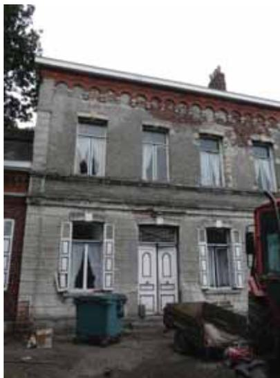
Le corps de logis principal s'élève sur deux niveaux (deux photos de gauche). Il se compose de six travées de fenêtres, dont les ouvertures sont en arc surbaissé. Les murs de briques, entièrement enduits au ciment, sont pourvus d'un décor alliant pilastres d'angles, bandeaux et corniches rappelant des bandes lombardes. L'ensemble est couvert d'un toit en croupe, en tuiles mécaniques.
