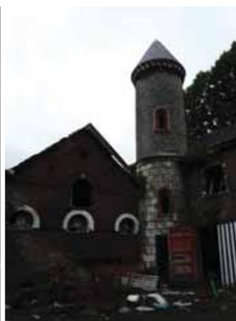
La tourelle d'escalier s'élève sur trois niveaux. Elle dessert tant ce logis que les parties haute de la dépendance agricole se trouvant de l'autre côté. Ses murs de briques sont recouverts d'un enduit, imitant pour les deux premiers niveaux, un appareillage régulier de pierre de taille, et pour le dernier étage un crépi ciment. Elle est couronnée d'une corniche et d'un toit conique en ardoises.
