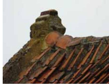
Les pannes créent une ondulation régulière sur les longs pans fortement inclinés des toitures. Elles sont très souvent maçonnées au mortier de chaux pour renforcer leur imperméabilité et pallier les déformations dues à la cuisson (photo ci-contre).
