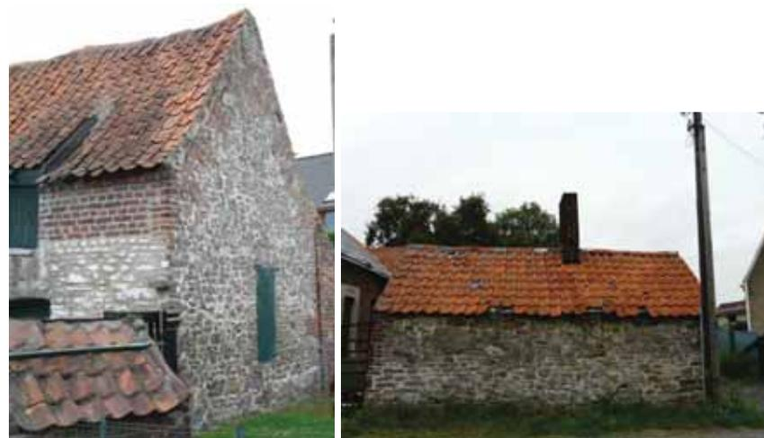
Ici, le grès est utilisé en moellons, tant sur le pignon d'une ancienne grange que sur les murs gouttereaux d'une petite dépendance agricole (sans doute un fournil).
