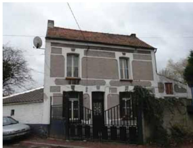
Ci-dessus, façade de maison de bourg recouverte d'un enduit en gravier roulé : bandes et bandeaux alternent, laissant place à des linteaux plus ouvragés.
