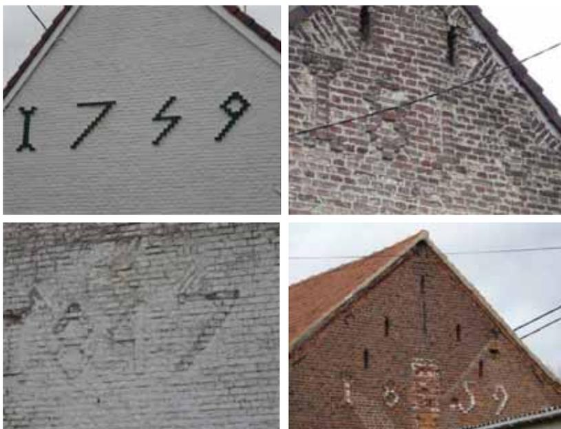
Exemples de briques posées sur champs sur les pignons de corps de ferme, permettant ainsi d'inscrire les dates de construction des bâtiments (respectivement : 1759, 1813, 1847 et 1859).
